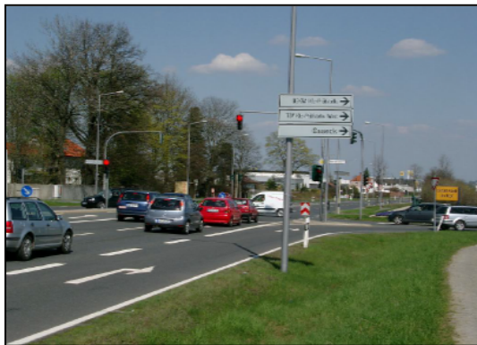
Foto 3: Separate Abbiegespuren und beampelte Übergangsmöglichkeiten zwischen den Gewerbegebieten Kulmbacher Straße Nord und Süd
